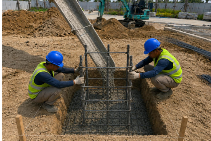
Anchor cage + concrete pouring
