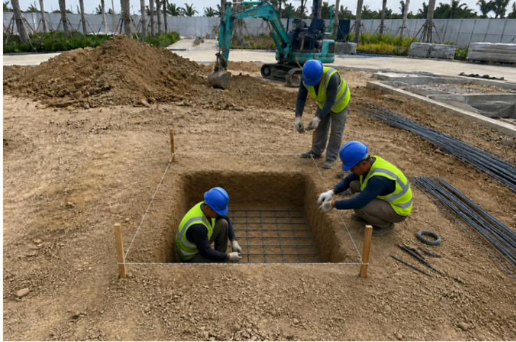
Bottom rebar layer
